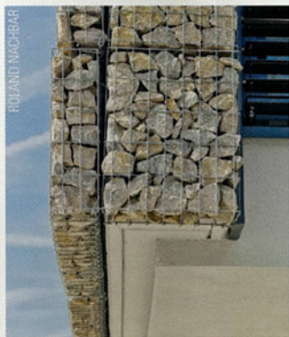
Muschelkalk, »verpackt« in eine Vorsatzschale aus Rothfuss-Wandverkleidungskörben, stellt den direkten Bezug zur Tätigkeit des Erdbauunternehmens Bauermees her.
